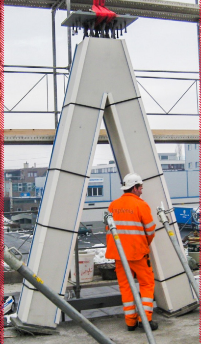
Die SACAC Stütze wird vom Bauarbeiter direkt auf dem Bau platziert
