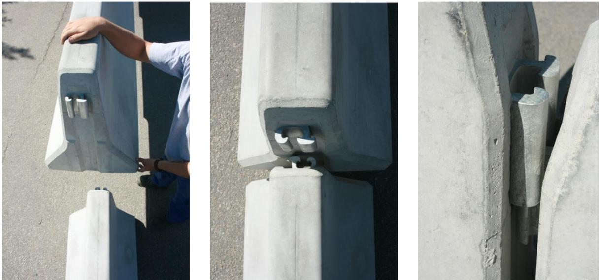
Nun wird die Stirnfläche des zu versetzenden Elements an die Stirnfläche des anschliessenden Elements geführt, sodass die beiden Kupplungen in der Draufsicht überlappen. Um Betonabplatzungen zu vermeiden, sollen die Elemente beim Manipulieren nicht aneinanderstossen.
